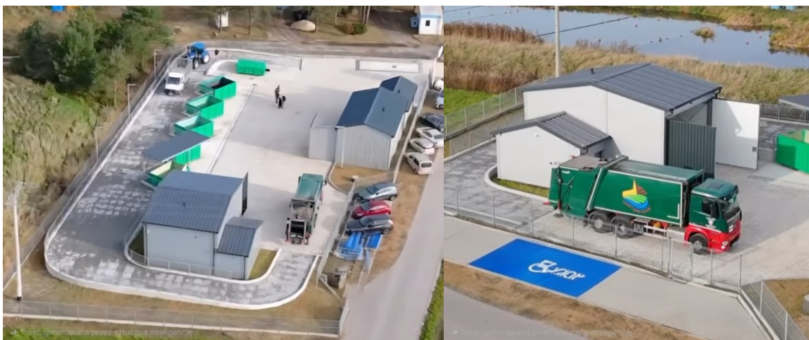
Rys.3. Punkt Selektywnego Zbierania Odpadów Komunalnych w Przyrowie
